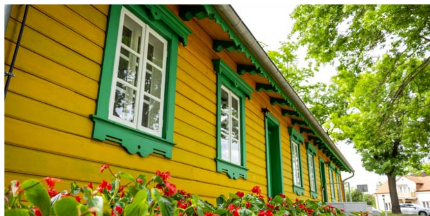
Odrestaurowany budynek dawnej Kolei Nadwiślańskiej
